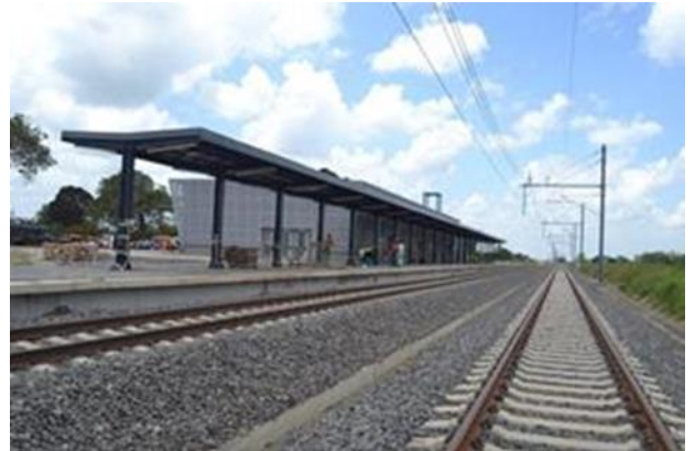
Reli ya Kiwango cha Kimataifa (SGR) Dar es Salaam – Morogoro
